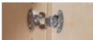
Extrem robuste Vollmetall-Scharniere mit 180° Öffnungswinkel
